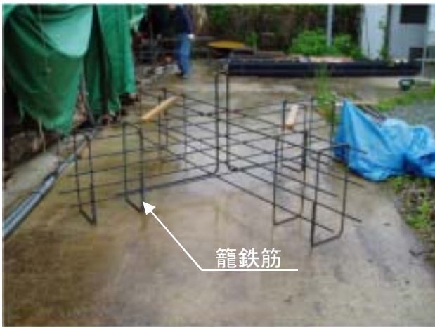
鉄筋組立状況
