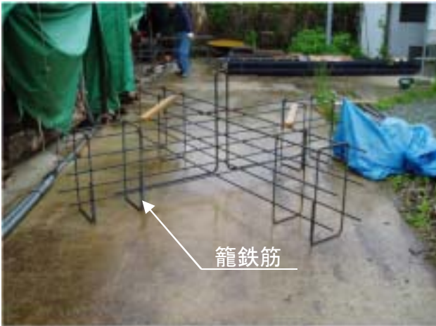
鉄筋組立状況
