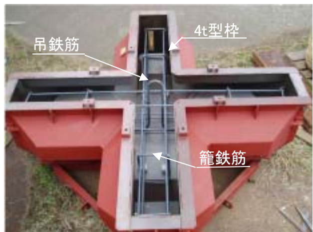
型枠組立状況
