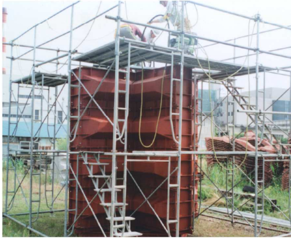
(4) コンクリート打設
