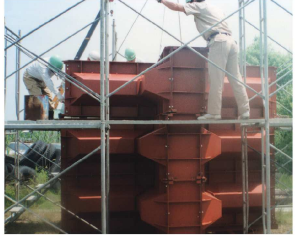
(3) 側枠組立(2段目～4段目)
