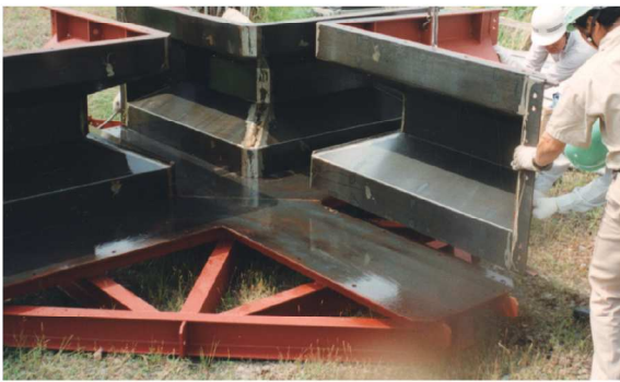
(2) 側枠組立(1段目)
