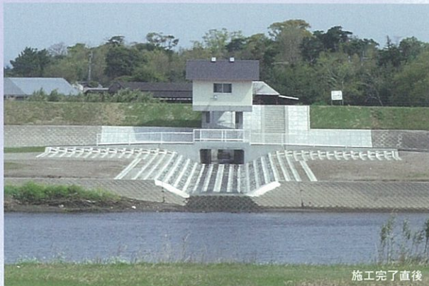
樋門の吐出口に、根固工と護岸工を一連に施工ができる植生護岸として採択されました。
