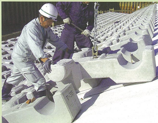
ブロックを単体で施工します。
