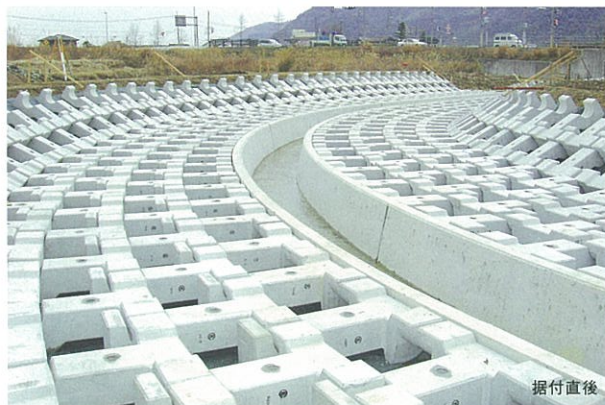
「植生と人が触れ合える空間づくり」と「曲線施工(R=20m)」の2点から豊かな空隙部を有し且つ地盤に対してフレキシブルで植生の活着にも優しい構造であるカメレオンが採択されました。
