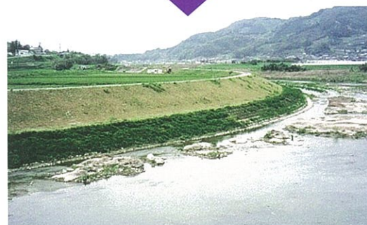
台風による出水後、3ヶ月
