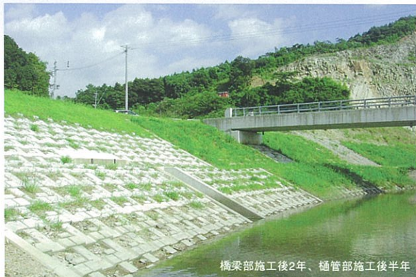
感潮区間で地盤がゆるく、沈下の恐れがある箇所でした。従来の橋台保護で行っていたコンクリートブロック張では沈下に伴い崩壊する可能性があった為、追従性の高いカメレオンが採択されました。
