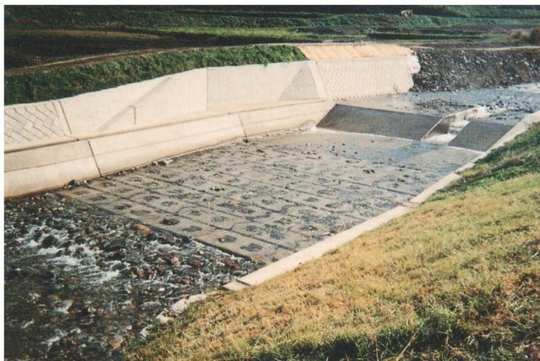
施工場所 青森県切明川 事業名 切明川局部改良工事 事業主体 弘前土木事務所 ブロック t 型 ビーチロック P I 型 3t
