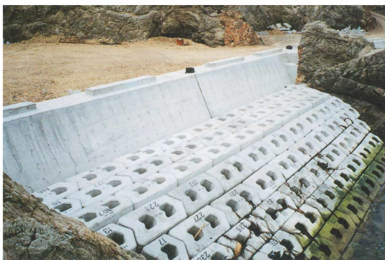
施工場所 三重県国崎地区海岸 事業名 国崎地区海岸国補海岸局部改良工事 事業主体 志摩土木事務所 ブロック t 型 ビーチロック P I 型 2t
