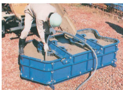
(4)コンクリート打設
