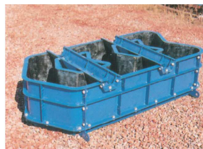
(3)型枠組立完了
