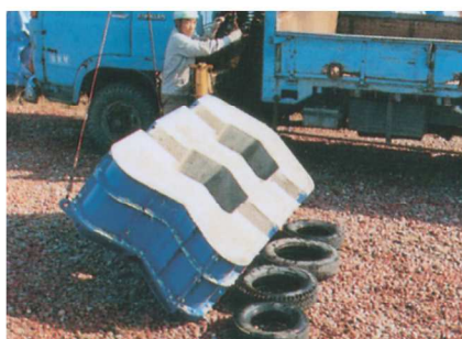
(7)型枠解体前ブロック反転
