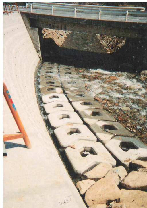
施工場所 岩手県遠野国道107号線 事業名 一般国道107号 藤沢橋地区橋梁災害復旧工事 事業主体 遠野土木事務所 ブロック t 型 ビーチロック P I 型 4/2t
